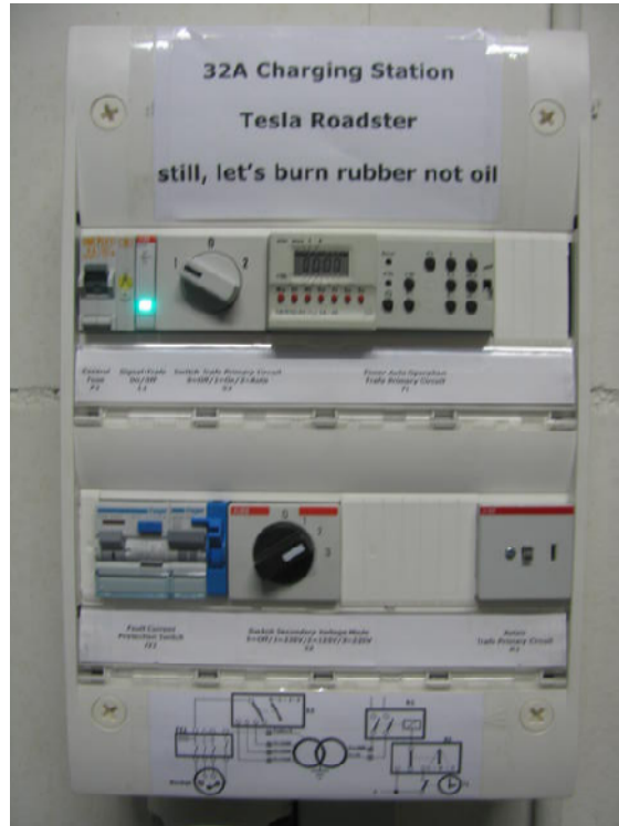
Verdrahtung Trenn-Transformator 1-phasig sek. 220V/32A, prim. 400V
